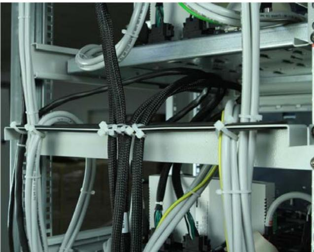
После выбора требуемой свободной длины, кабели крепятся пластиковыми стяжками к фиксатору кабеля.
