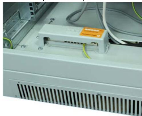
Рис. 50: Принцип подключения защитного (PE) и функционального (FE) заземления
