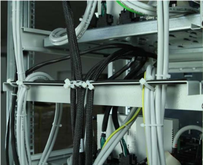
Рис. 38: Установка фиксаторов кабеля
