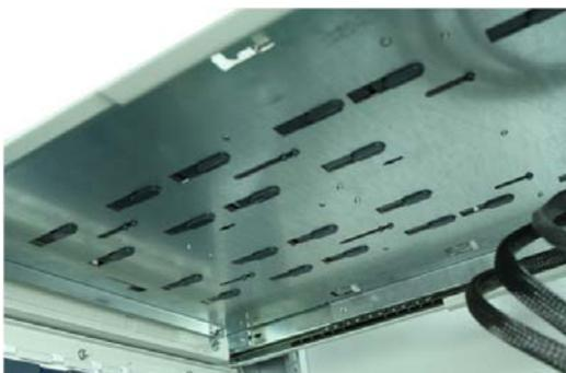
Основание ящика ПКП (вид снизу) с платформами расширения, вставленными в прорези.
