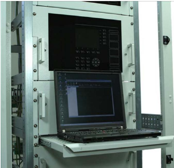
В выдвинутом положении, сервисный лоток может использоваться, например, для размещения настроечного компьютера.
